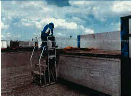
墜落・転落防止：昇降台の導入
